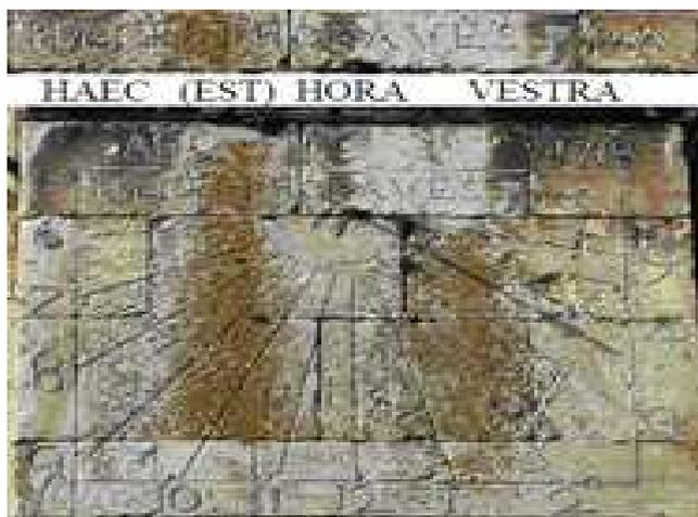
Reloj 2. Radial en junta de sillar. Vertical declinante a levante.
